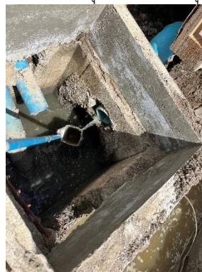
รูปที่ 3.56 การเก็บตัวอย่างคุณภาพน้ำทิ้ง บริเวณระบบบำบัดน้ำเสียสำเร็จรูป
